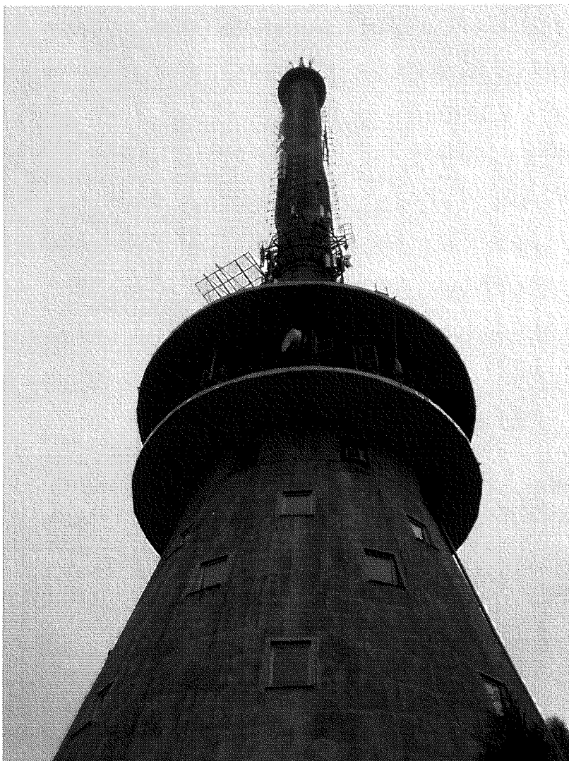
Zdjęcie 1 Badany obiekt
