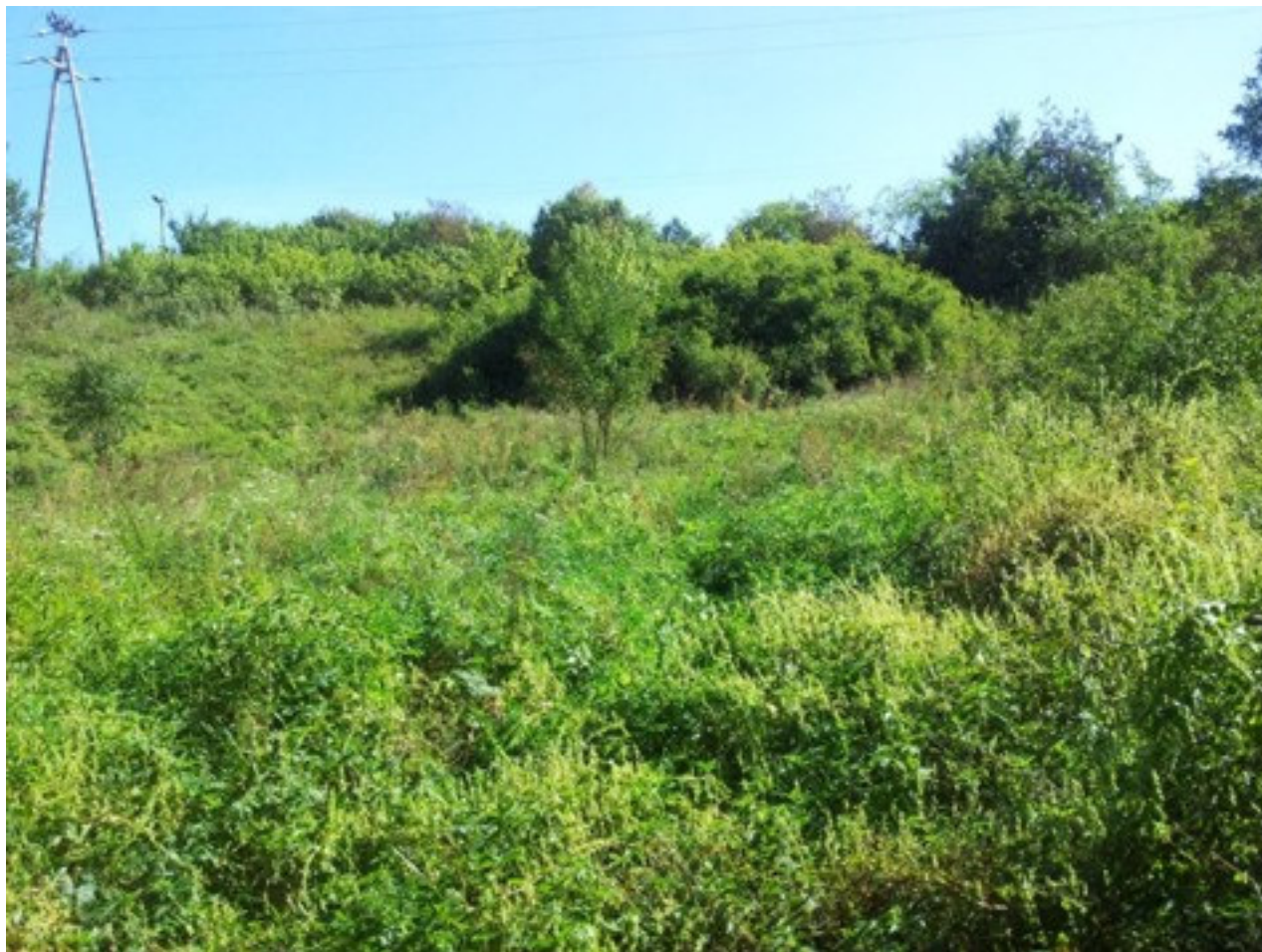
Ryc. 5. Widok skarpy głównej i części środkowej osuwiska w Wesolej
