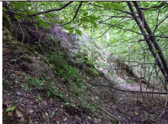
Świeża skarpa górna osuwiska
