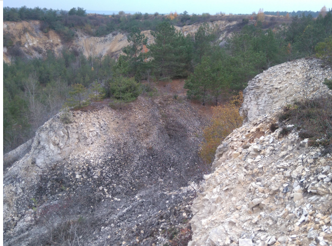
Widok oberwanego pakietu skalnego (lewa strona zdjęcia) poniżej skarpy głównej.
