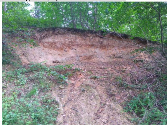
Widok skarpy głównej osuwiska.
