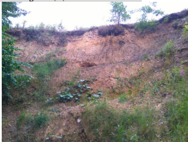
Widok skarpy głównej osuwiska.
