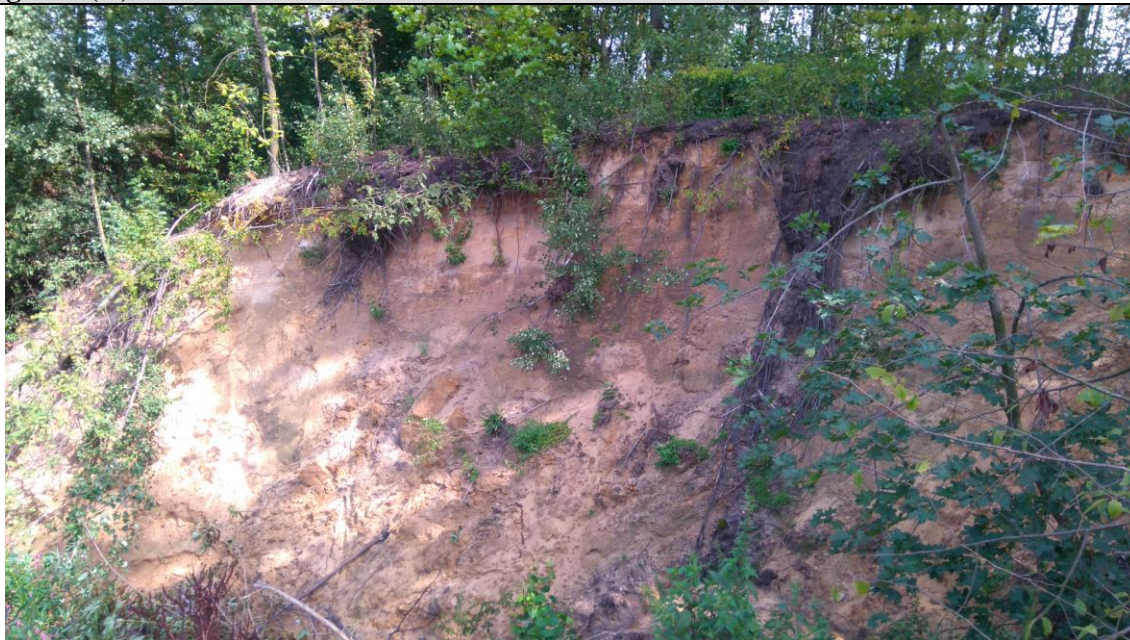
Widok ogólny osuwiska, widoczny jego gruntowy charakter.
