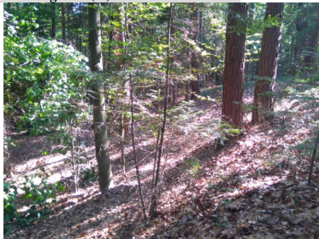
Widok osuwiska w rejonie skarpy głównej.
