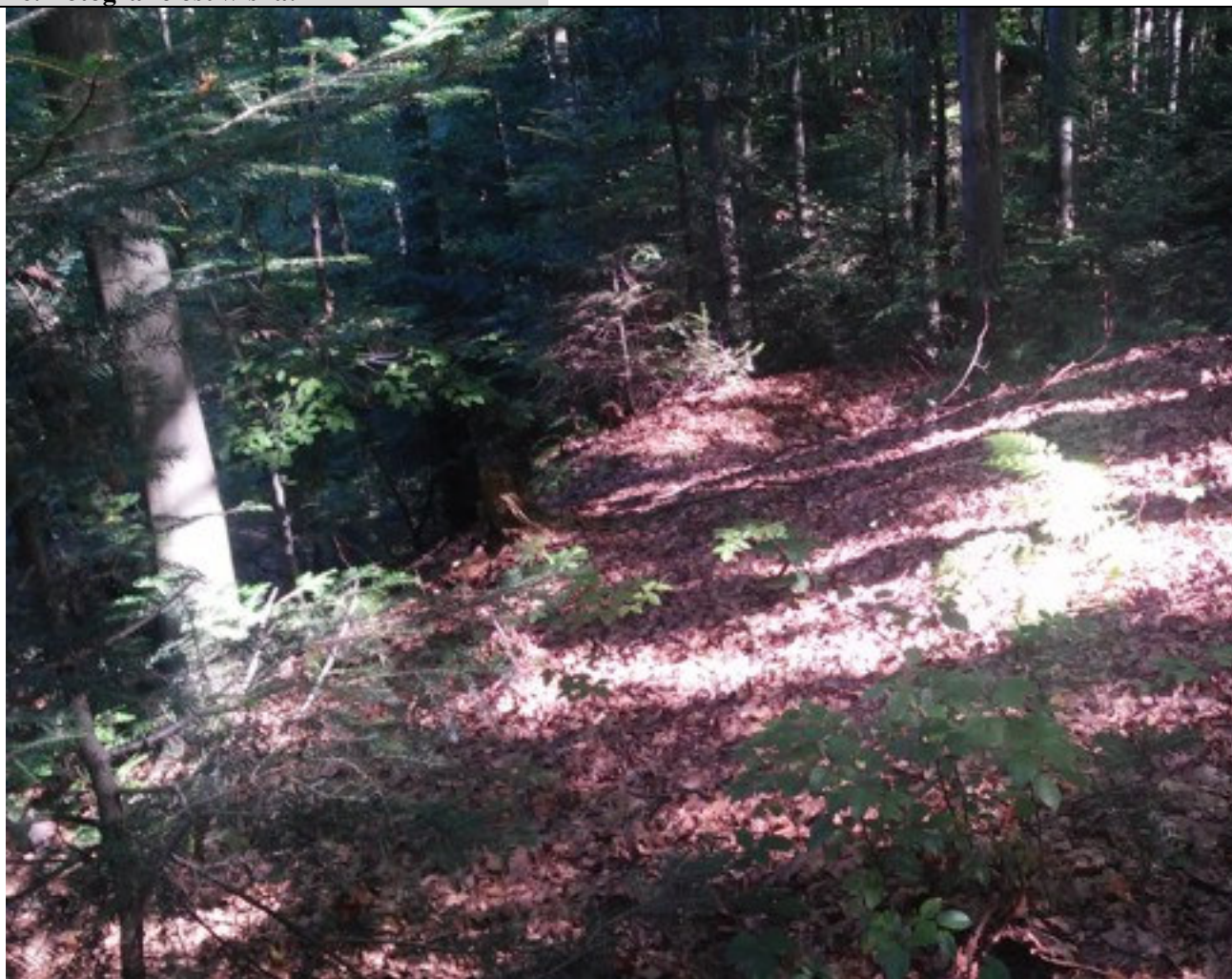
Ogólny widok osuwiska.
