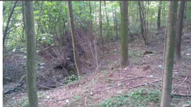
Dolna, przykorytowa część osuwiska
