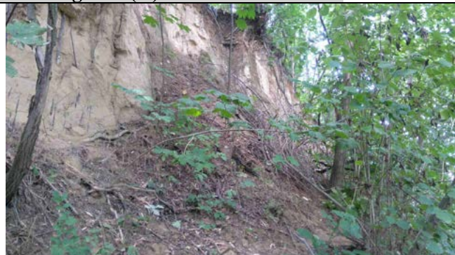
Skarpa główna osuwiska
