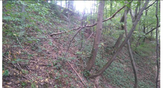
Skarpa główna osuwiska
