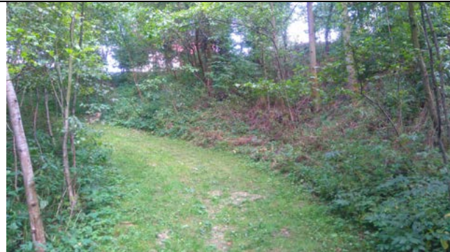
Droga gospodarska przebiegająca przez osuwisko
