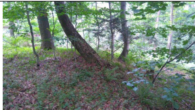
Powierzchnia koluwalna w dolnej części osuwiska
