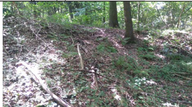
Skarpa główna osuwiska
