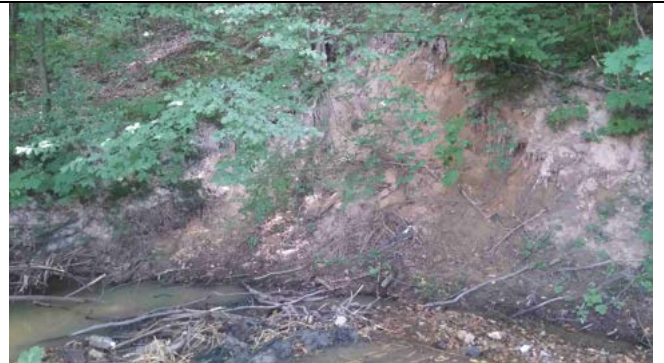
Koluwia w dolnej części osuwiska erodowane przez wody potoku
