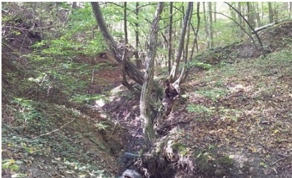
Widok jezora osuwiskowego.
