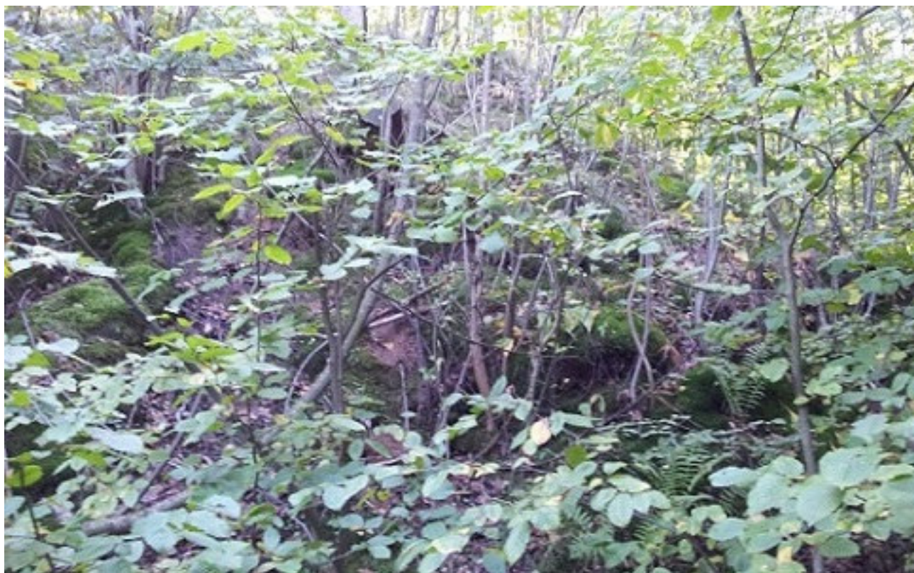
Widok niszy i skarpy głównej osuwiska
