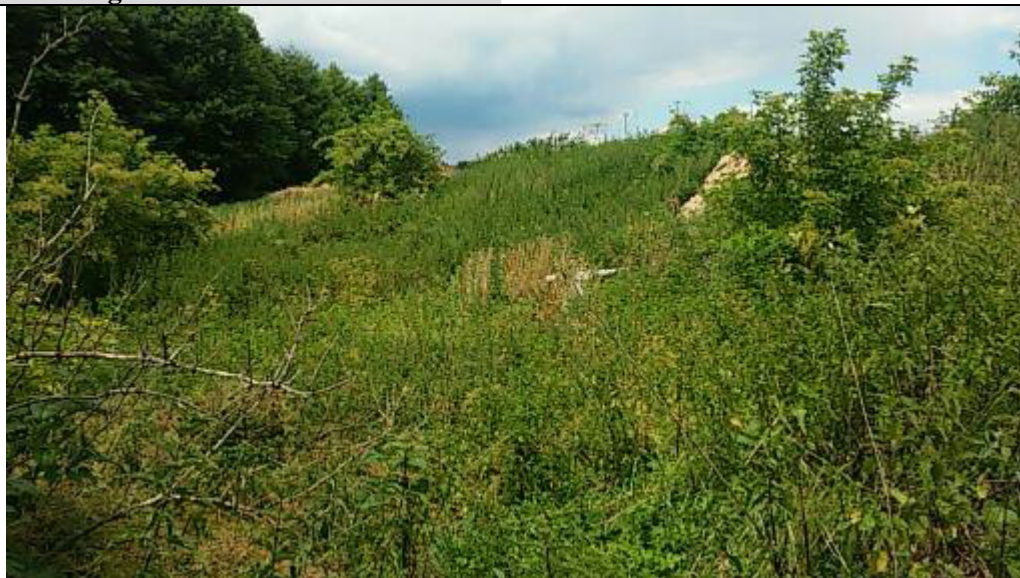
Ogólny widok osuwiska.
