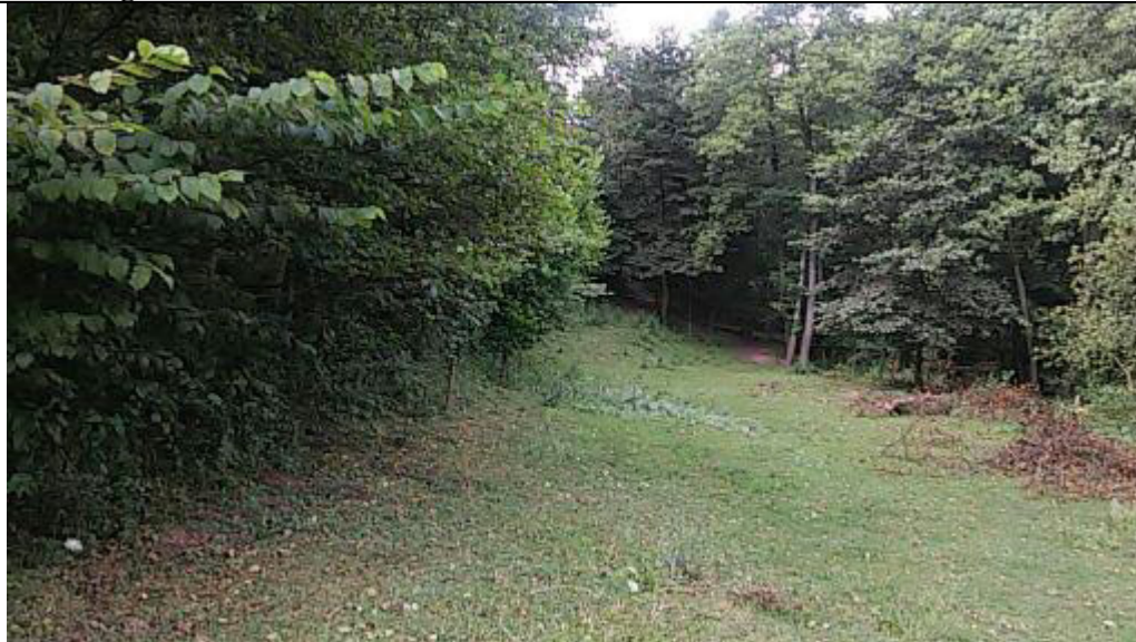
Ogólny widok osuwiska.
