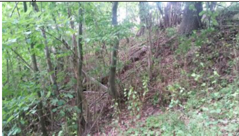
Ogólny widok osuwiska.
