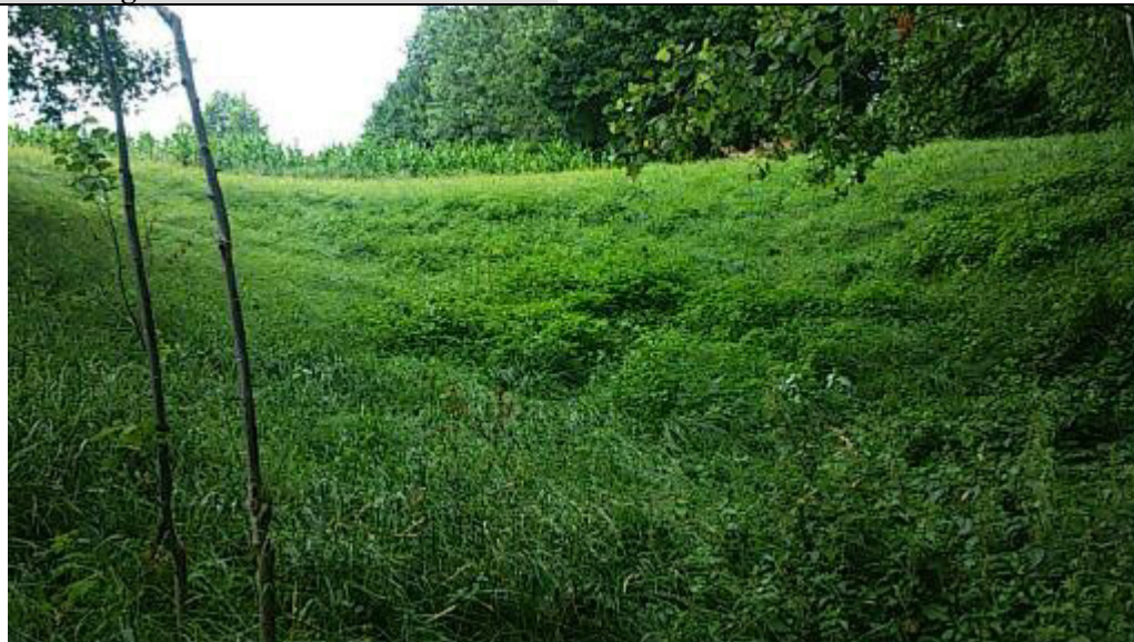
Ogólny widok osuwiska.
