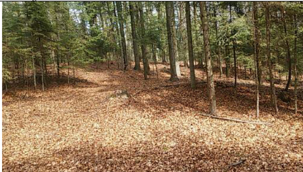
Ogólny widok osuwiska.
