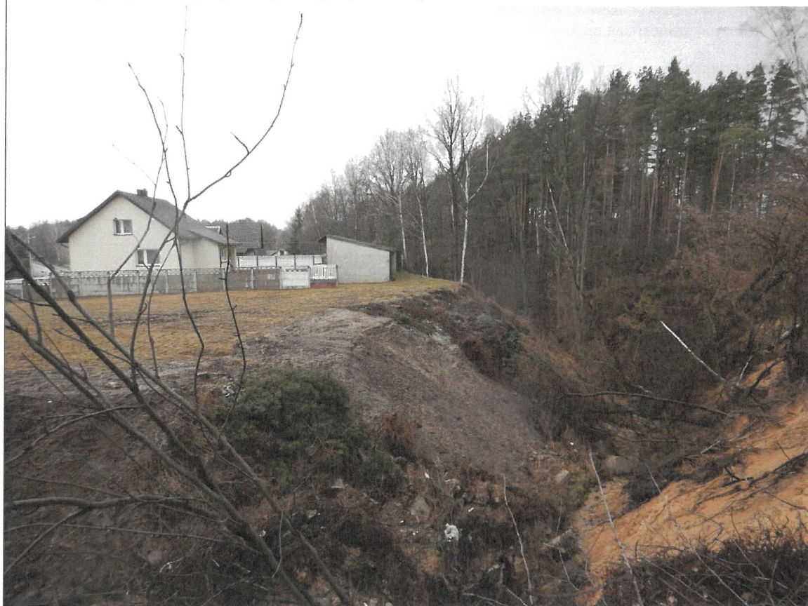
Fot.5 Nadbudowa antropogeniczna nad lewym zboczem wąwozu.
