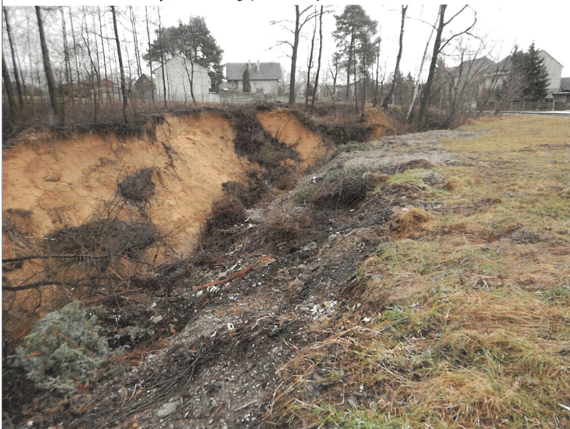
Fot.3 Materiał antropogeniczny i osuwisko 83121 (powiększone)
