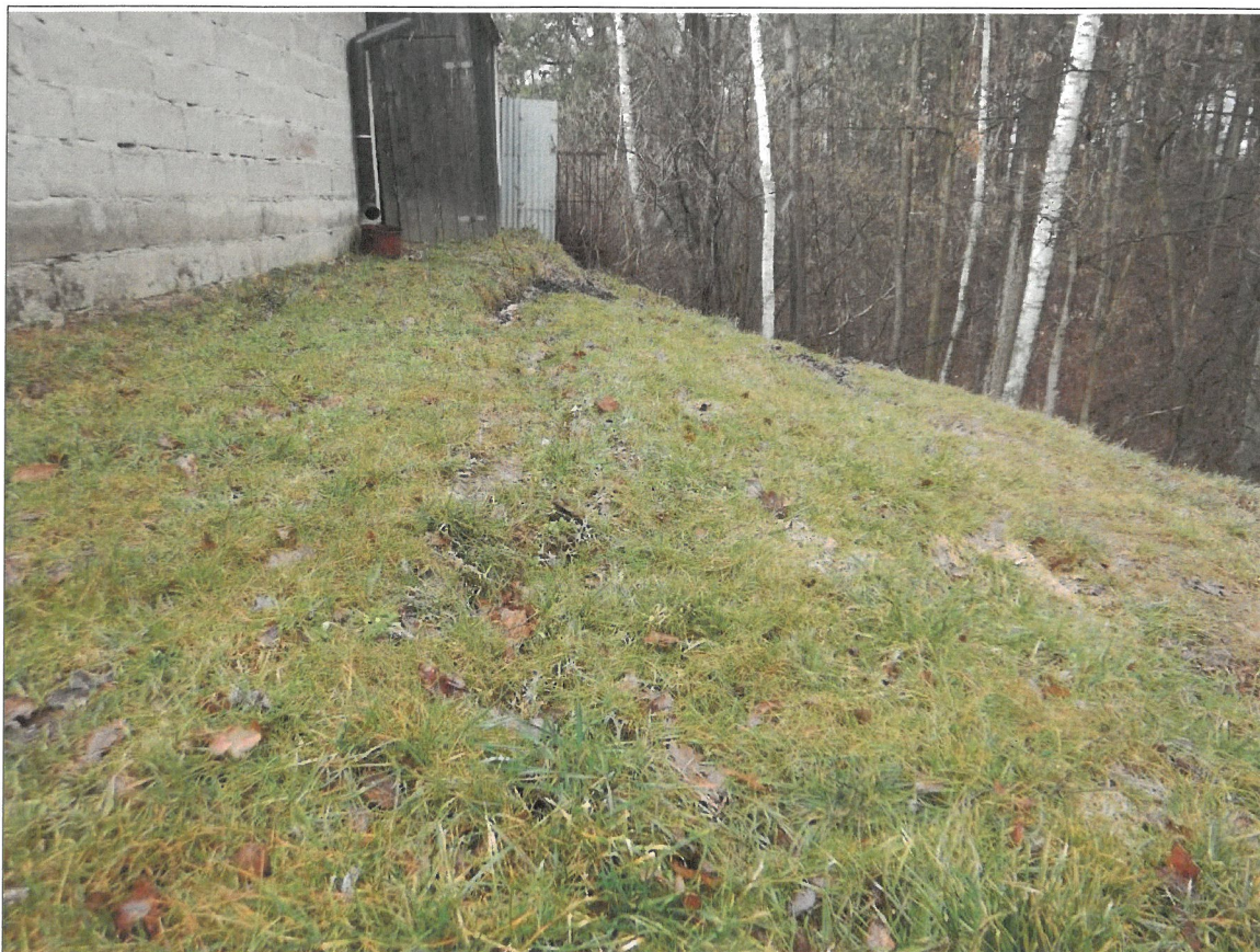
Fot.1 Skarpa główna przy budynku gospodarczym.
