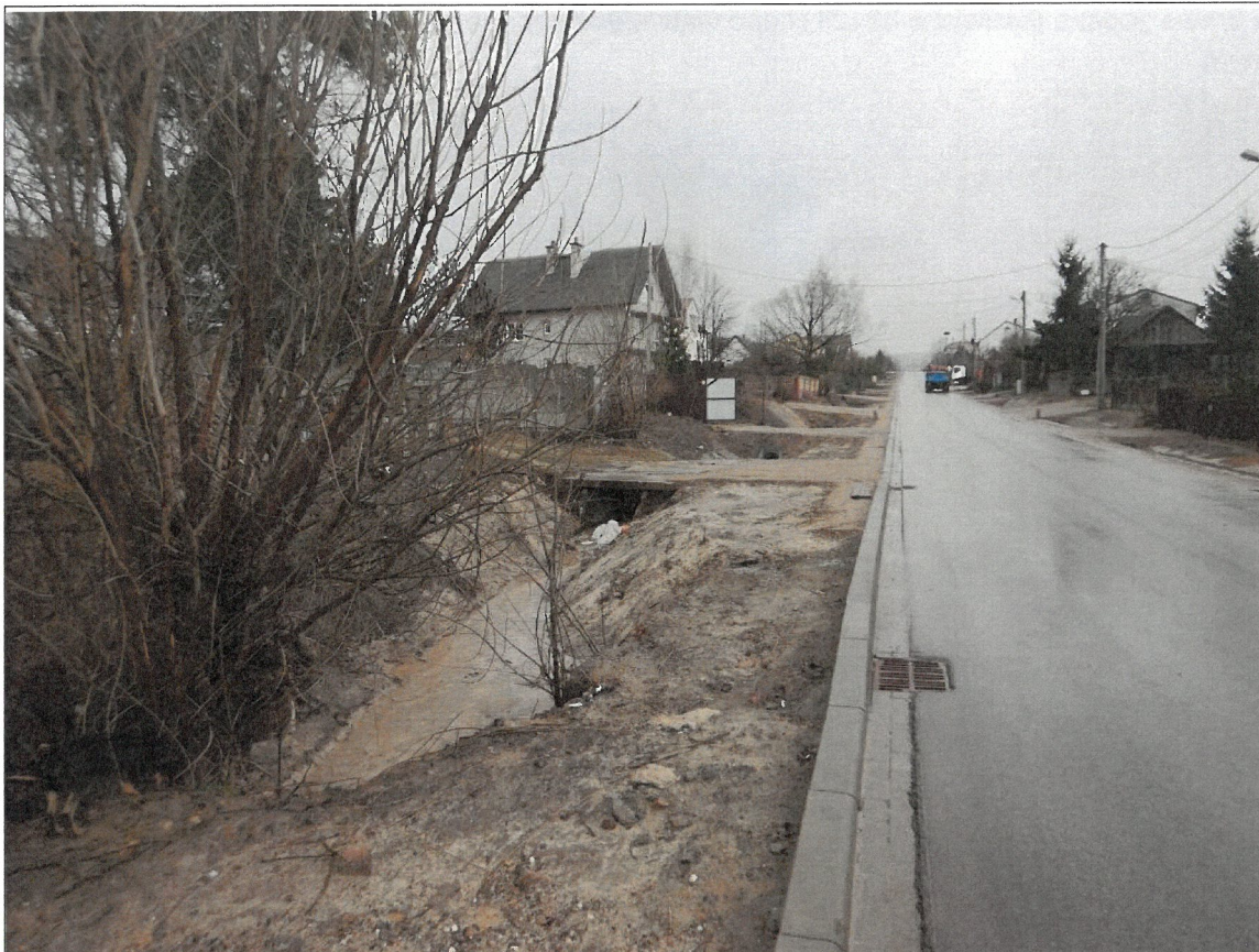
Fot.6 Rów odwodnieniowy wzdłuż drogi powiatowej.
