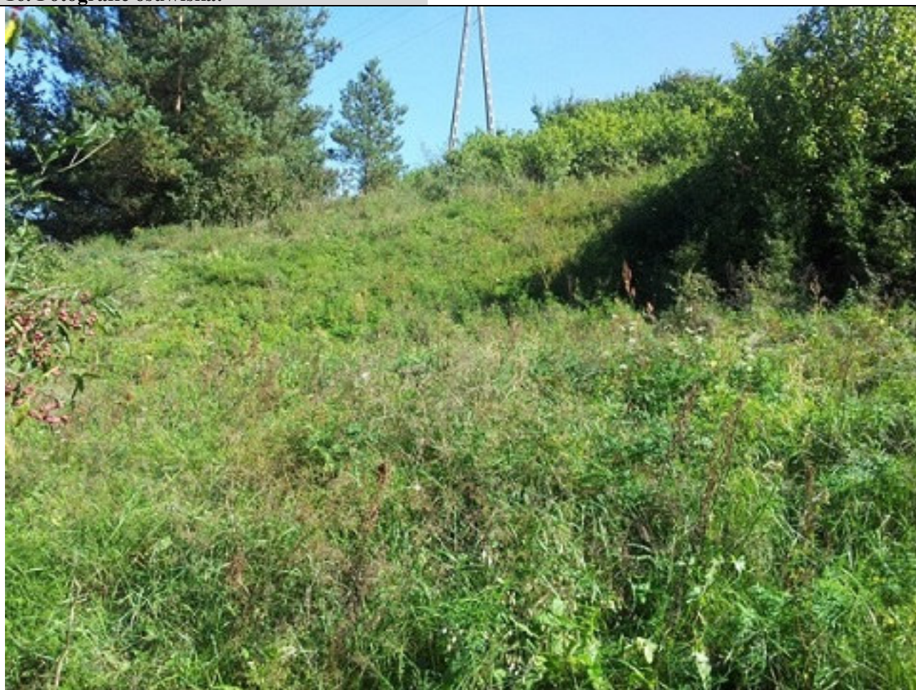
Widok górnej części osuwiska z zarośniętą skarpą boczną.
